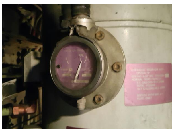
Мал.5 Показчики рівня гідравлічної рідини в резервуарах «А» та «В» 27.01.2016р.
