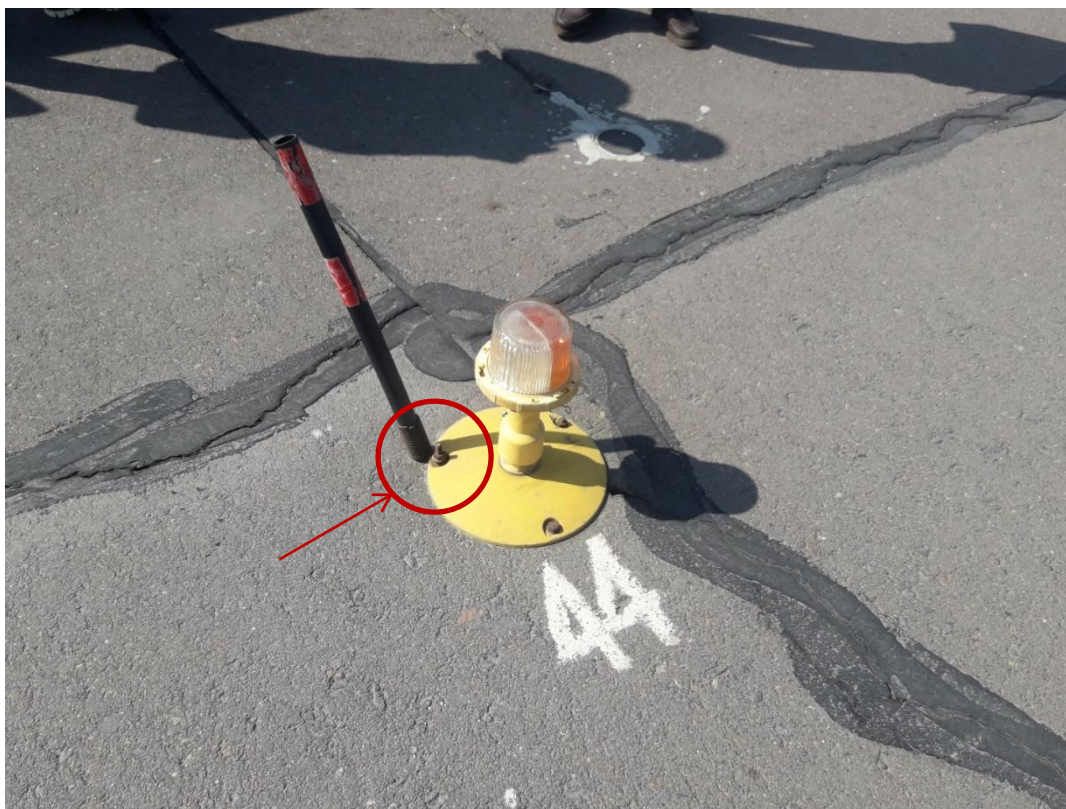
Рис. 7. Фото відновленого бічного вогню ЗПС № 44
