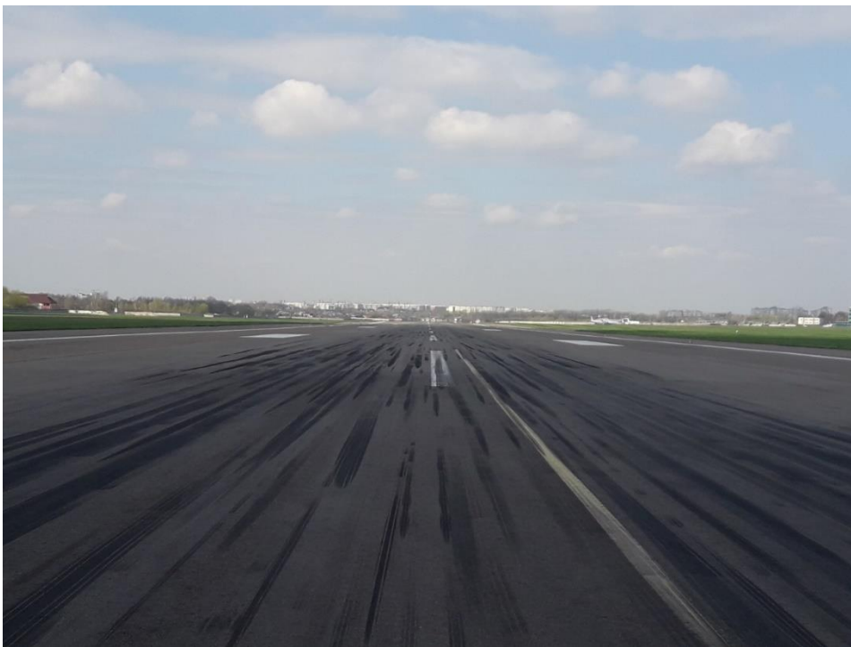
Рис. 8. Фото стану маркування осьової лінії ЗПС
